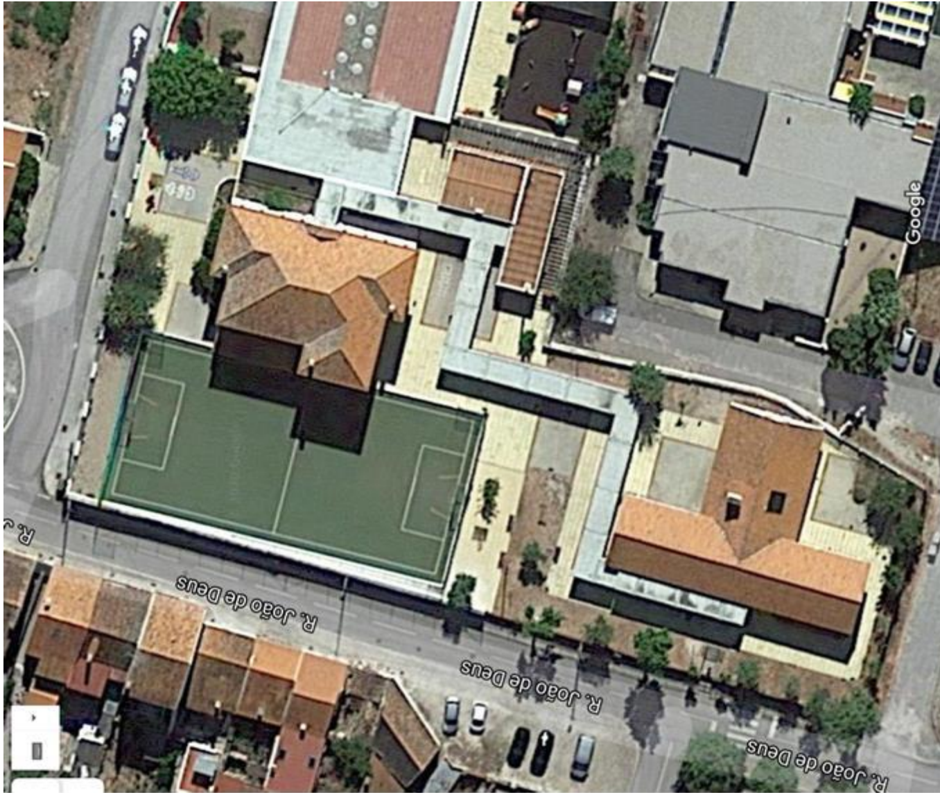
Fotografia aérea da EB1 de Alcains
